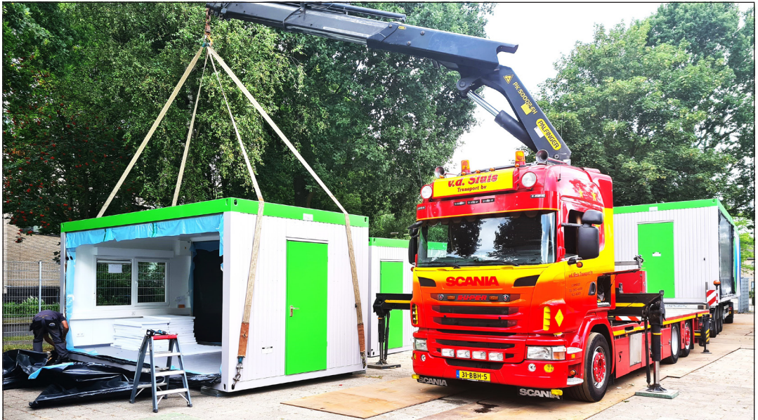
° Op de eerste dag van de schoolvakantie werden bij De Blokkendoos noodlokalen geplaatst. Die zijn nodig in verband met een verbouwing. Naar verwachting blijven ze tot de kerstvakantie staan. (Foto: Ruud Peters)
