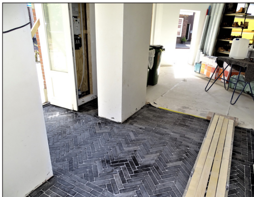
° De bestrating vanaf het terras zal doorlopen tot in het pand, waar deze al deels is aangebracht.
