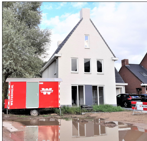
° Nog even en dan zijn alle 'bouw-uitingen' in Molenwijk-Zuid verdwenen.
