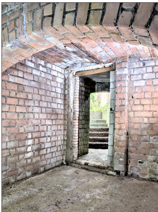
° Ingang van de schuilkelder van binnenuit gezien. (Foto: Evelien Mank-Ijpelaar)
