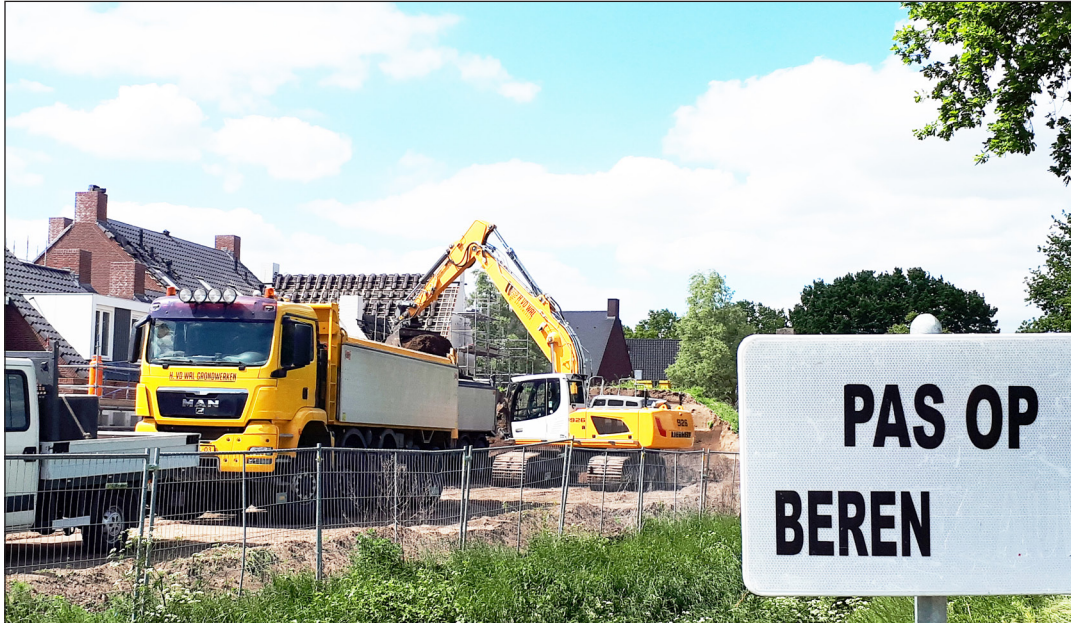
°Bij het bouwproject Molenwijck-Zuid wordt flink gewerkt aan het verwijderen van zwarte grond. Ruud Peters, die deze foto maakte, kwam hier gelukkig geen 'beren' tegen!
