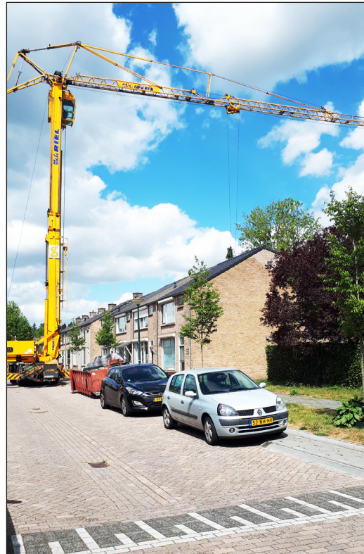
° Een flinke kraanwagen moest donderdag 30 april worden ingezet om in de Van den Hummelstraat bouwelementen over een woning te tillen. (Foto: Ruud Peters)
