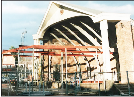
° De huidige 'Kiosk' in aanbouw in 1999. (Eigen foto)
