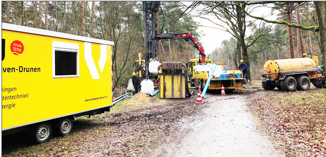
° Aanleg waterput. Vorige week maakten we deze foto van de aanleg van een waterput in de Loonse duinen. Locatie: langs het fietspad van Bosch en Duin naar de Leugenbenkskes, op het kruispunt van Het Land van Kleef met de Baden Powellweg. De put is bedoeld om in geval van bosbrand voldoende water bij de hand te hebben, aldus de makers van de put. (Foto: RdT)
